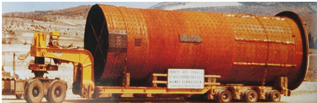
Convoiage du blindage d'un silo
